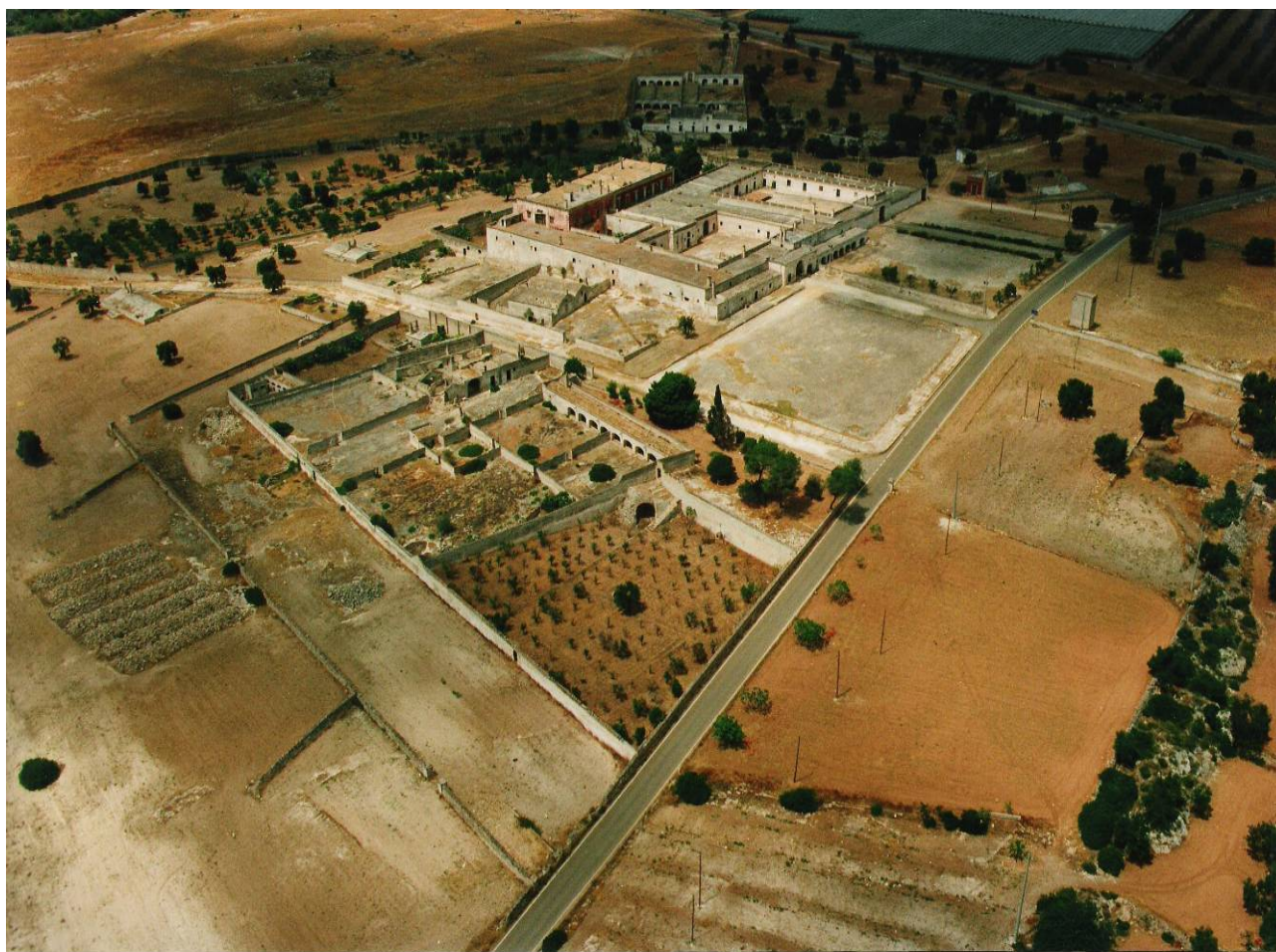
Figura 5.0 – Aereo foto verso del Complesso Masseria Accetta Grande
